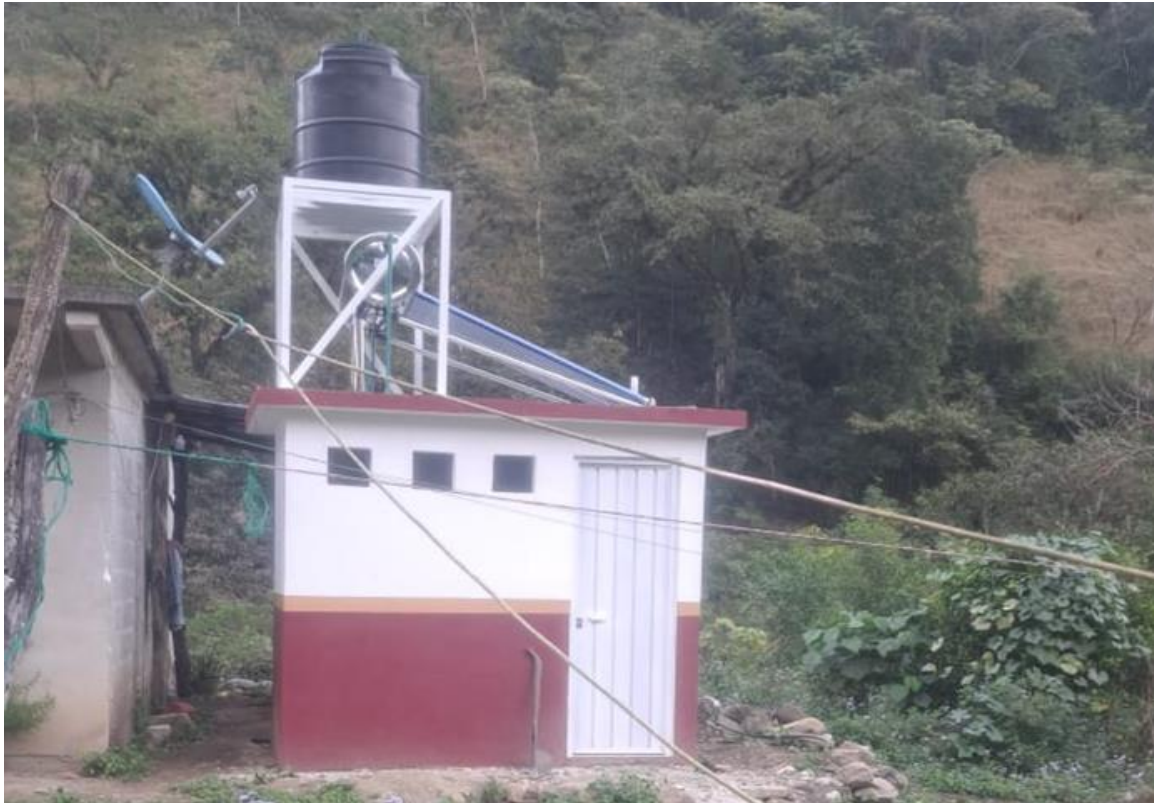
Imagen 59. Construcción de cuartos para baño con biodigestor y calentador solar.
