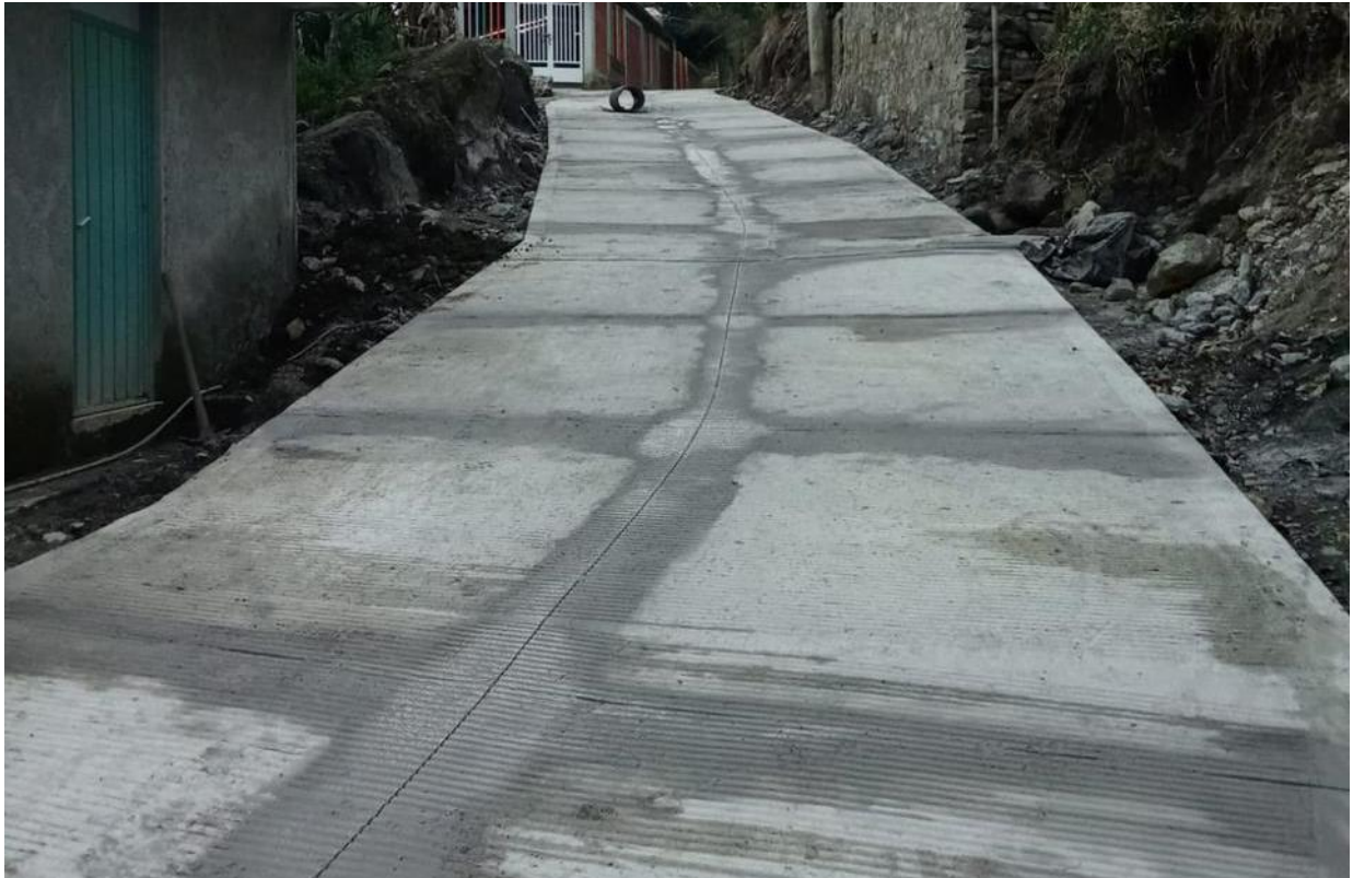
Imagen 63. Construcción de pavimentación y drenaje sanitario en Media Cuesta.
