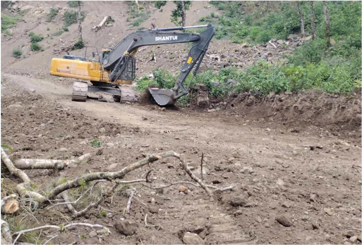
Imagen 74. Rehabilitación de Brecha Piedra Larga - San Antonio.
