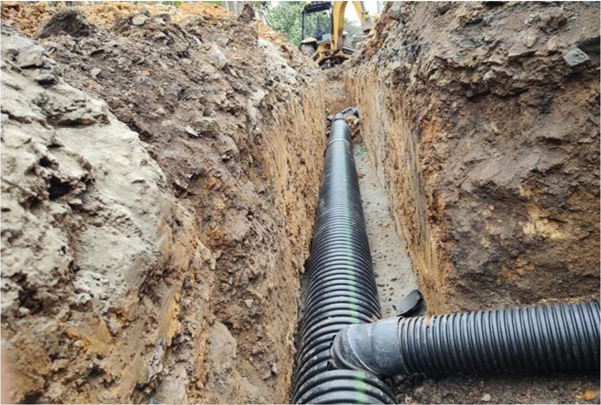
Imagen 71. Construcción de drenaje sanitario en Calle Las Palmas.
