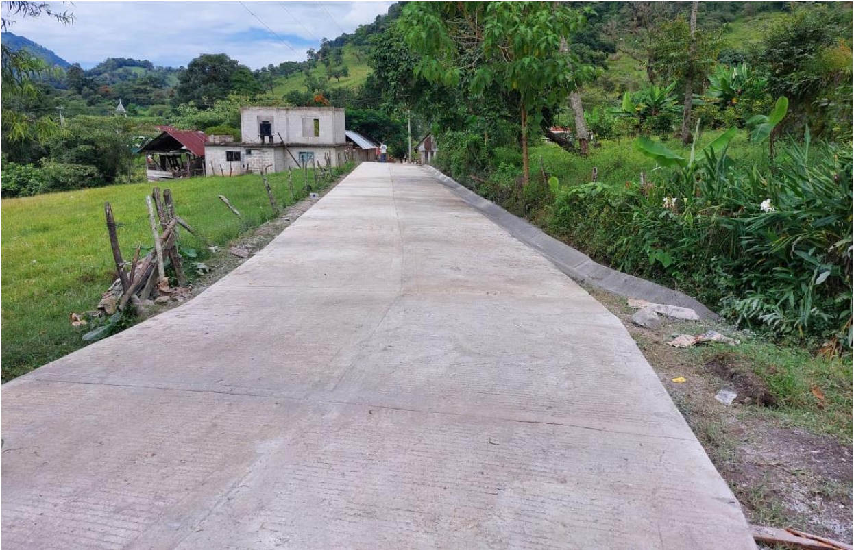
Imagen 61. Construcción de pavimentación hidráulica en acceso al Centro de Salud.
