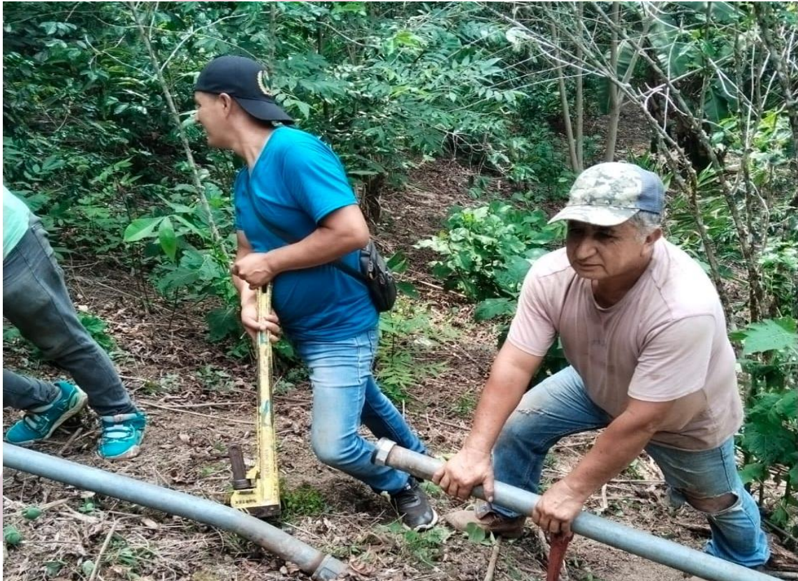
Imagen 57. Rehabilitación de la red de agua potable en Huasquilla.
