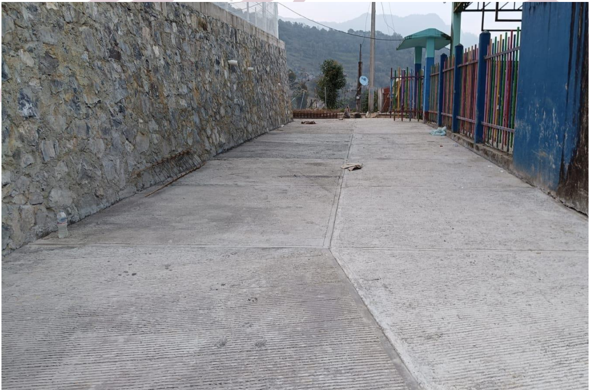
Imagen 66. Construcción de pavimentación hidráulica en Huasquilla.
