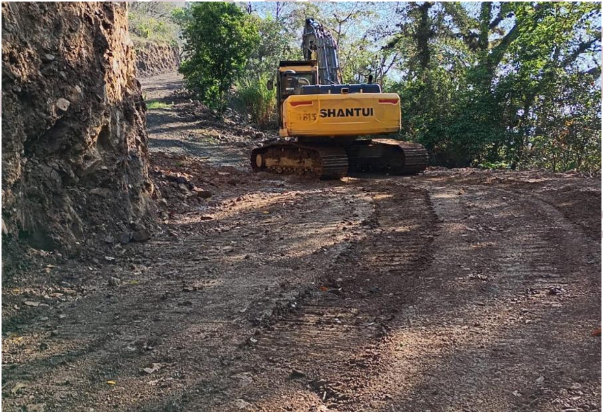
Imagen 73. Rehabilitación de Brecha Mavodo - La Huahua.
