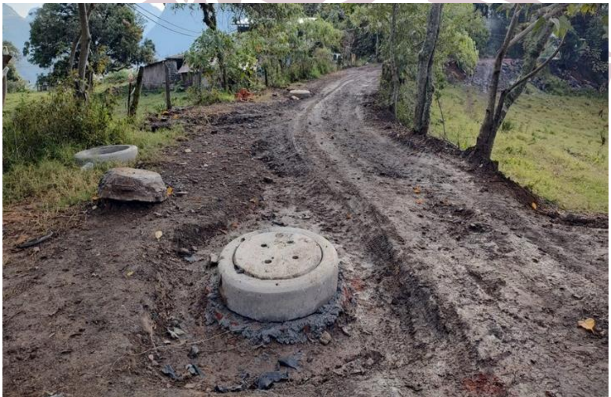
Imagen 70. Construcción de drenaje sanitario en acceso a Colonia El Mirador.
