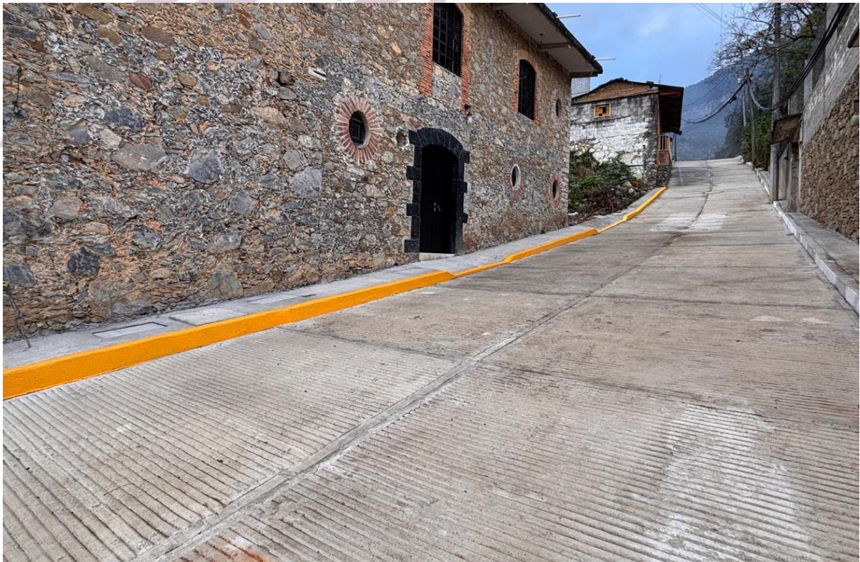
Imagen 64. Construcción de pavimentación y drenaje sanitario en Calle Libertad.
