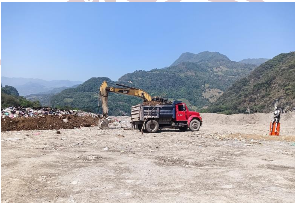
Imagen 75. Mantenimiento del relleno sanitario.
