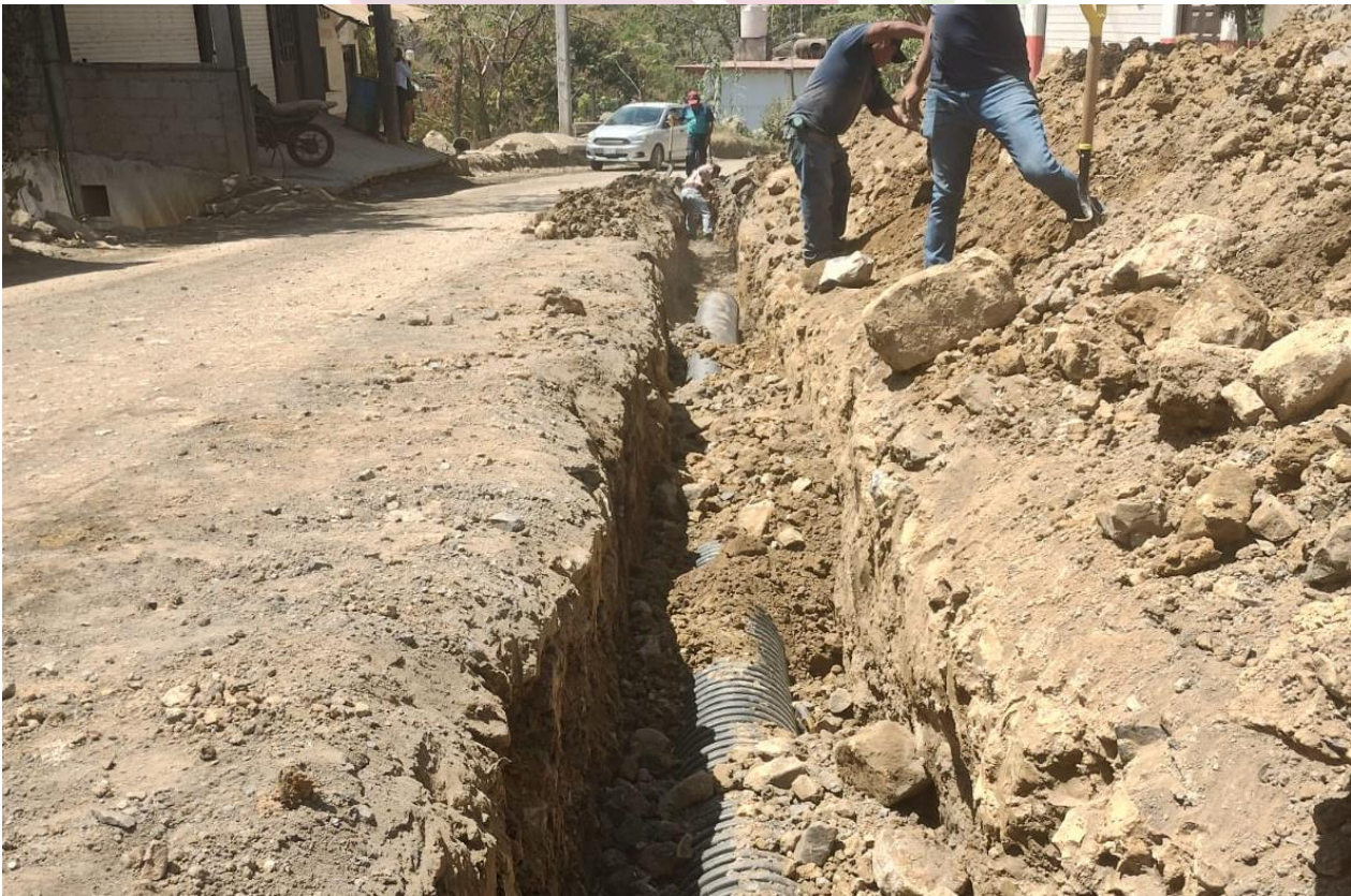
Imagen 56. Rehabilitación de drenaje en la Colonia Industrial.
