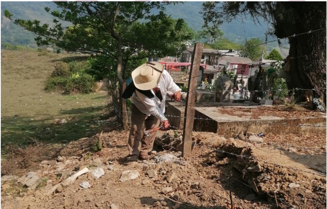
Imagen 76. Reforzamiento del cercado perimetral.
