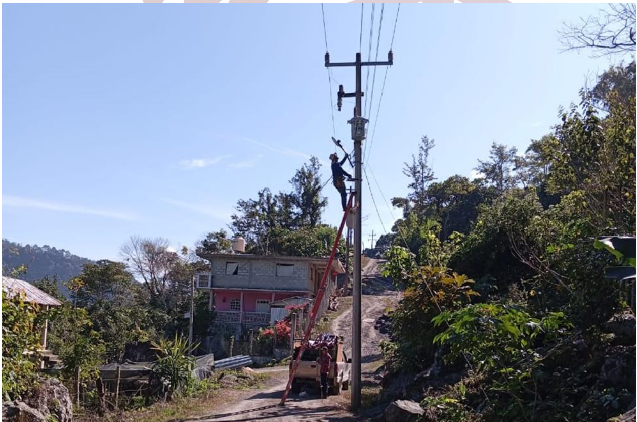
Imagen 77. Colocación de nuevas lámparas Led.
