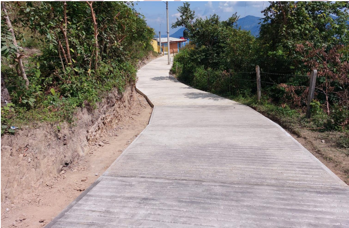
Imagen 68. Construcción de rampas de concreto en Palo Gordo.
