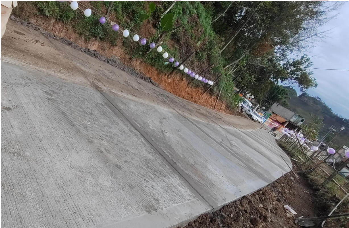
Imagen 60. Construcción de pavimentación hidráulica en La Venta.
