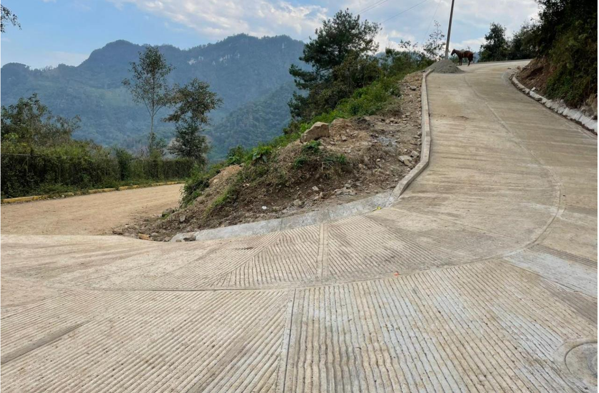
Imagen 65. Construcción de pavimentación hidráulica en acceso principal a Xuchitlán.
