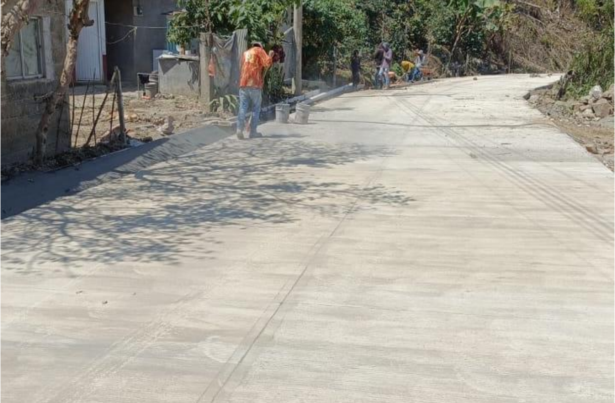
Imagen 67. Construcción de pavimentación hidráulica en acceso a El Mavodo.
