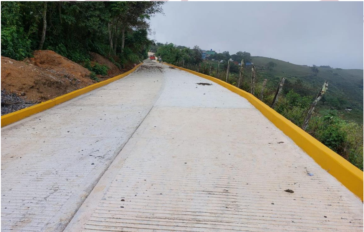
Imagen 62. Construcción de pavimentación hidráulica (segunda etapa) en cruce Palo Gordo.
