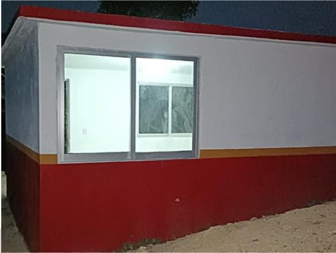
Imagen 58. Construcción de cuarto dormitorio.
